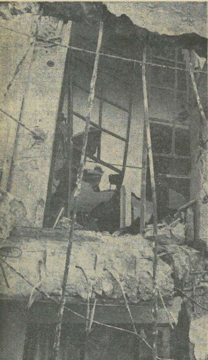
As traseiras da casa de Lopes Cardoso destruídas por uma bomba
