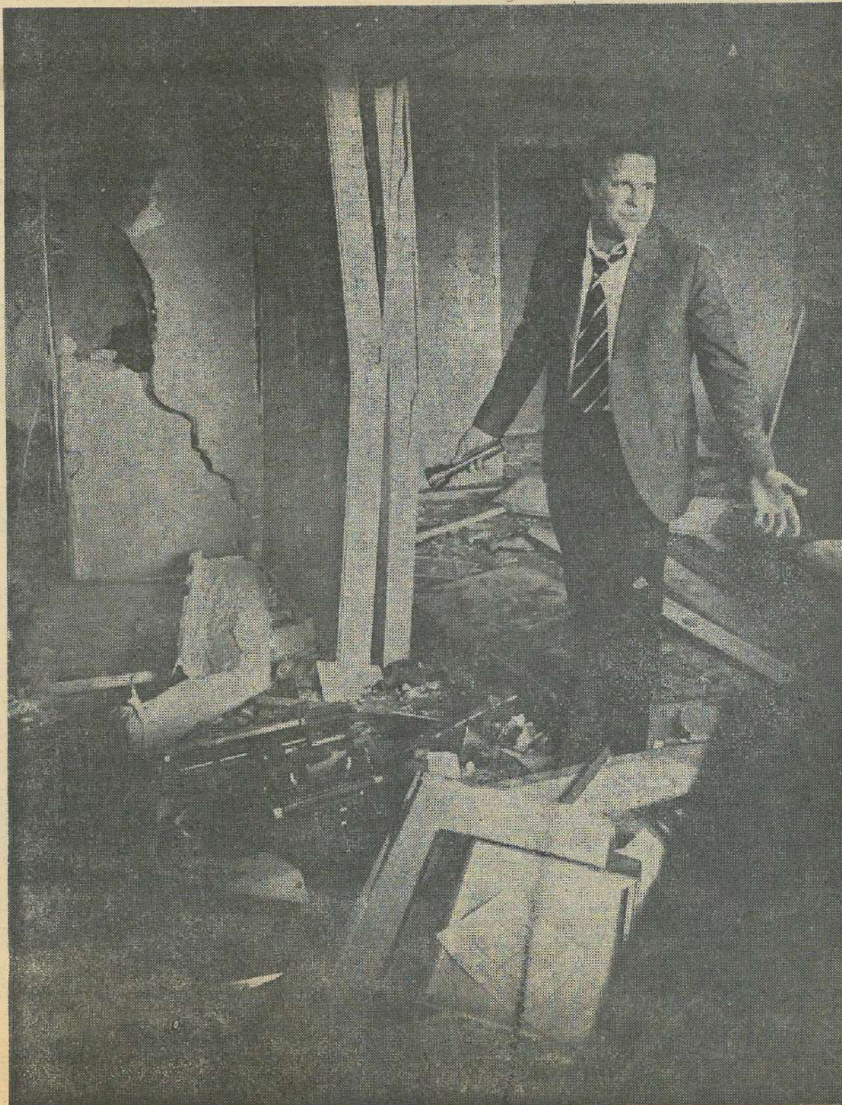
O embaixador de Cuba, Astray Rodrigues, percorre as instalações da chancelaria destruídas por uma forte carga explosiva
