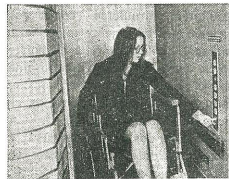
No mesmo bloco de apartamentos, os botões do elevador estão colocados abaixo nível, para poderem ser accionados por pessoas em cadeiras de rodas
