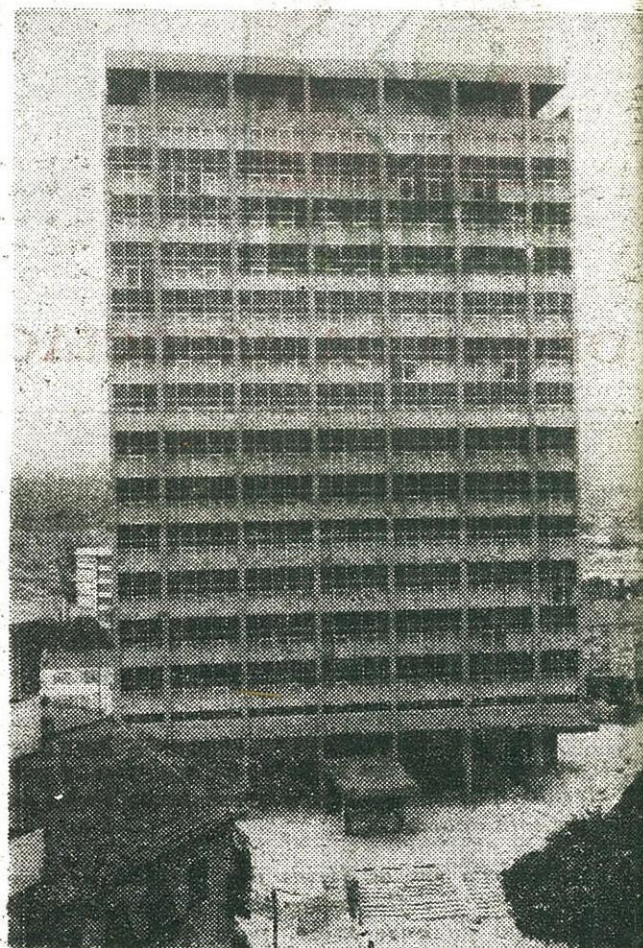
O grande imóvel de M.A.S., em Viseu, além das adaptações interiores, passa a dispor também de rampa exterior, em fase de acabamentos
